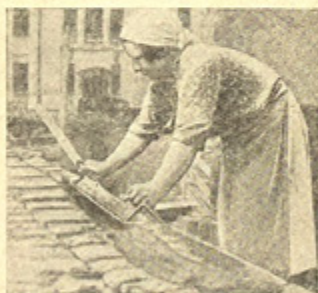
Рис. 17. Расстилание раствора под ложком внутренней версты
