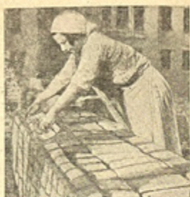
Рис. 16. Расстилание раствора ковшом т. Ширкова под ложком наружной версты
