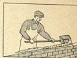
Рис. 18. Расстилание раствора на стену ковшом-лопатой т. Мальцева
